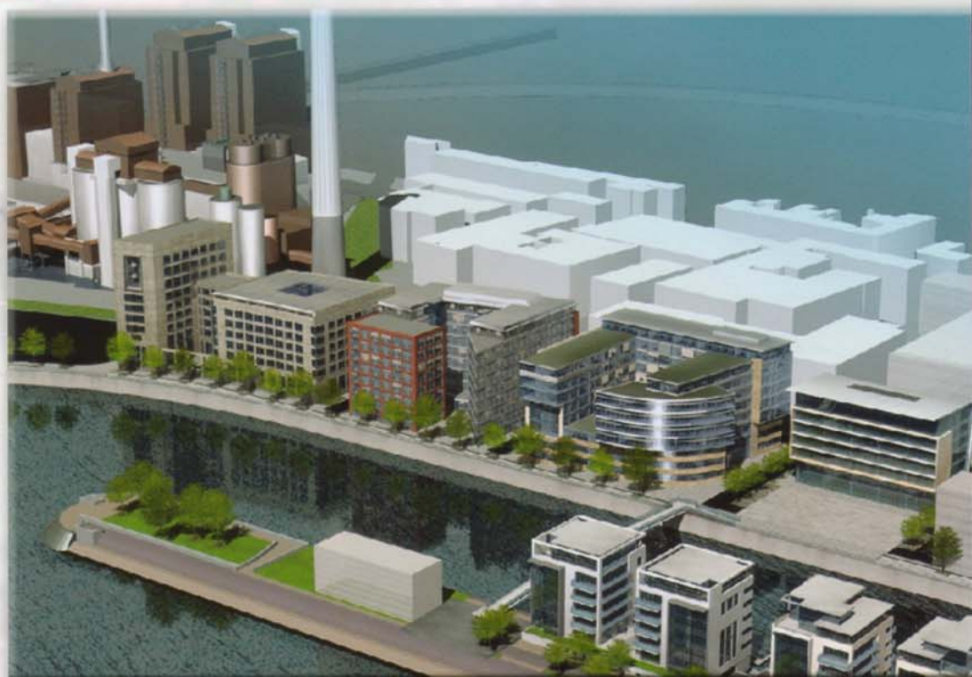
Für das Projekt Frankfurt Westhafen hat ein unabhängiges Beratungsunternehmen aus Frankfurt verschiedene Schnittstellen getestet (Bild: OFB, Frankfurt).
